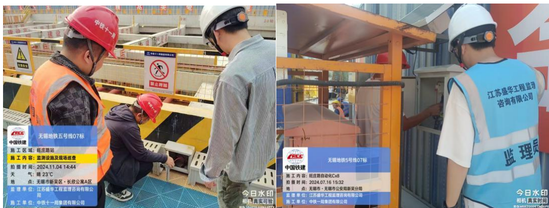
图5 自动化监测轴力元器件安装实拍图
