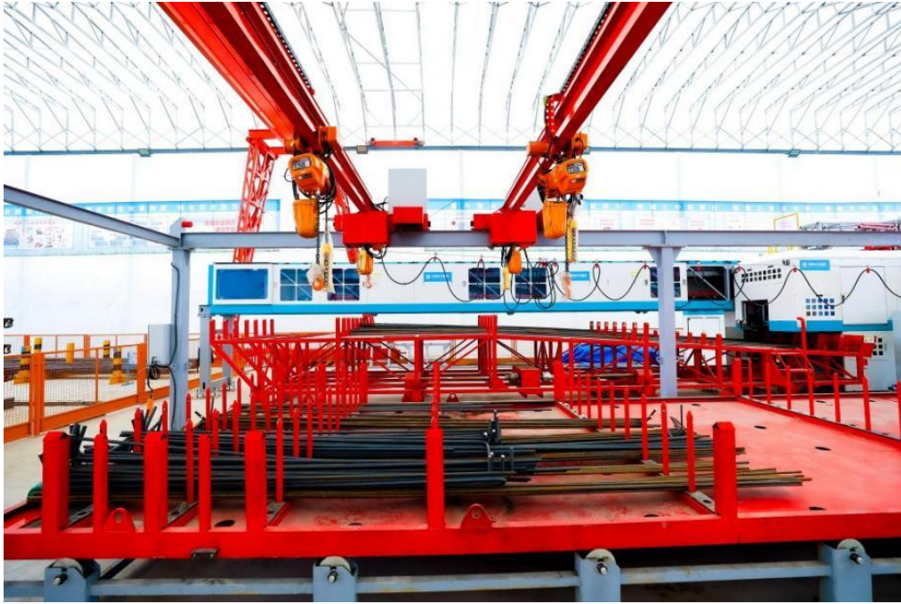
图7-9 钢筋智能加工生产线
