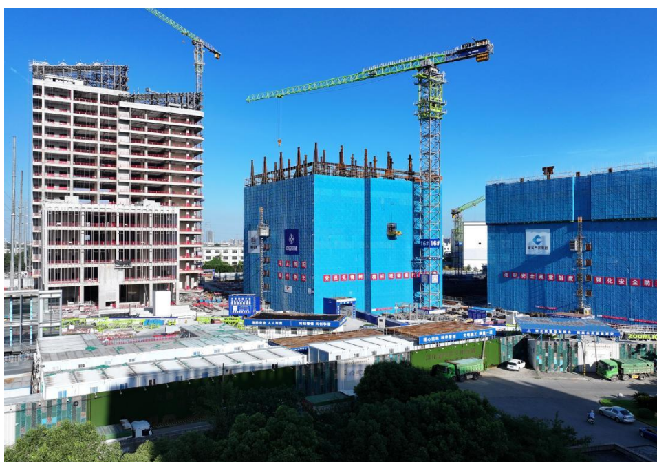
图2 项目施工现场实景
