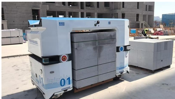
图9 N型物料运输机器人运输砌体照片
