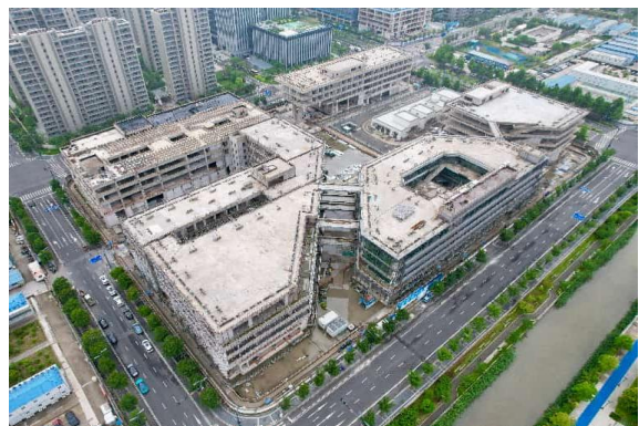
图 2 项目施工现场实景图
