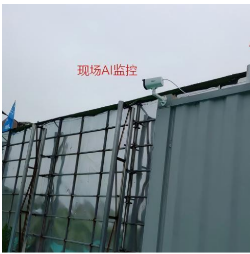
图4 临建外立面 AI 监控枪机实拍
