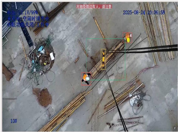
图9 司机操作端，十不吊AI预警
