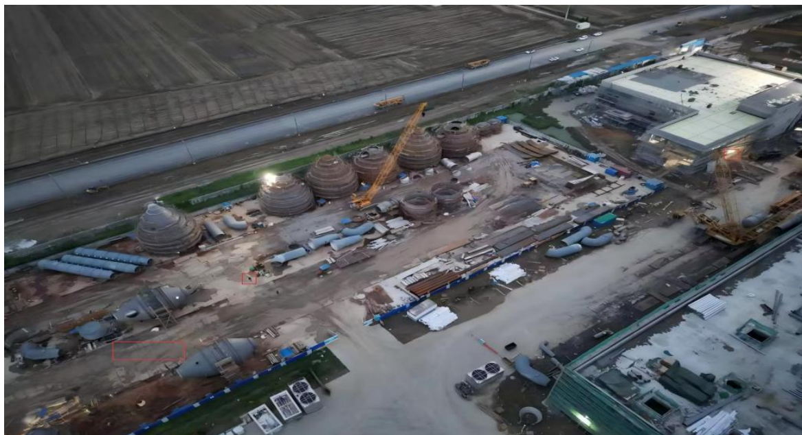
图6 夜间施工监测
