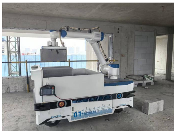
图7 码垛机器人现场施工照片
