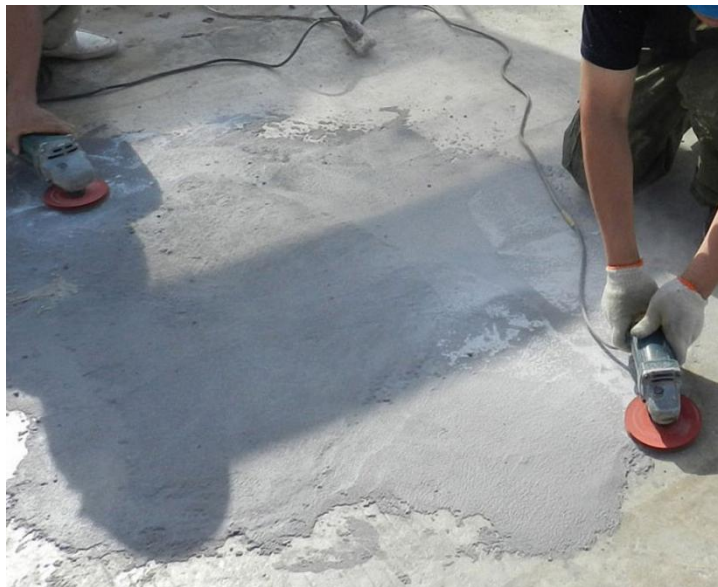
图9 局部地坪修复
