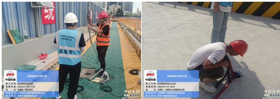
图4 自动化水位监测元器件安装实拍图
