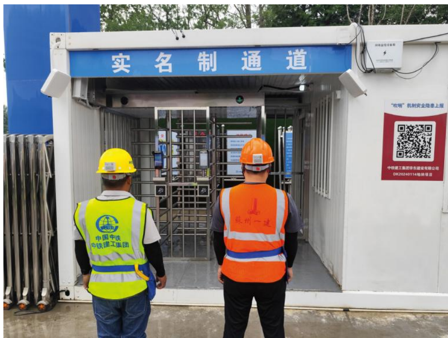
图 5 实名制道闸与智能安全帽联动核验
