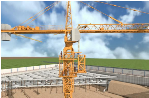
图11 塔吊顶升BIM技术交底
