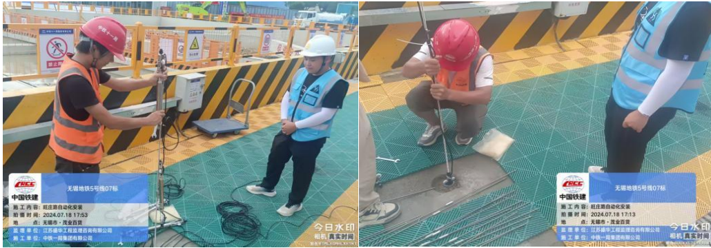
图3 自动化监测测斜元器件现场安装实拍图
