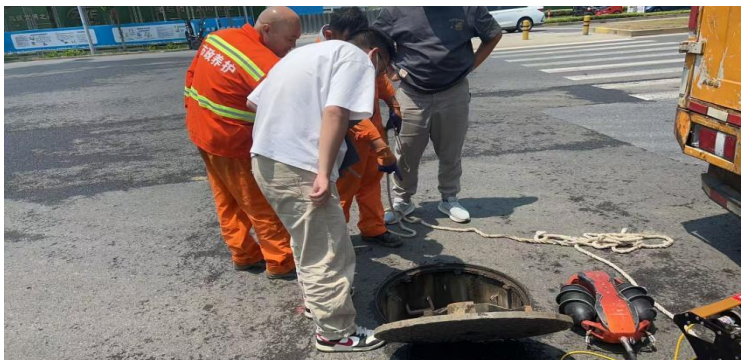
图9 常州市龙江北路管道检测
