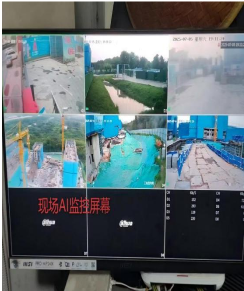
图5 监控中心多画面AI监控大屏实拍
