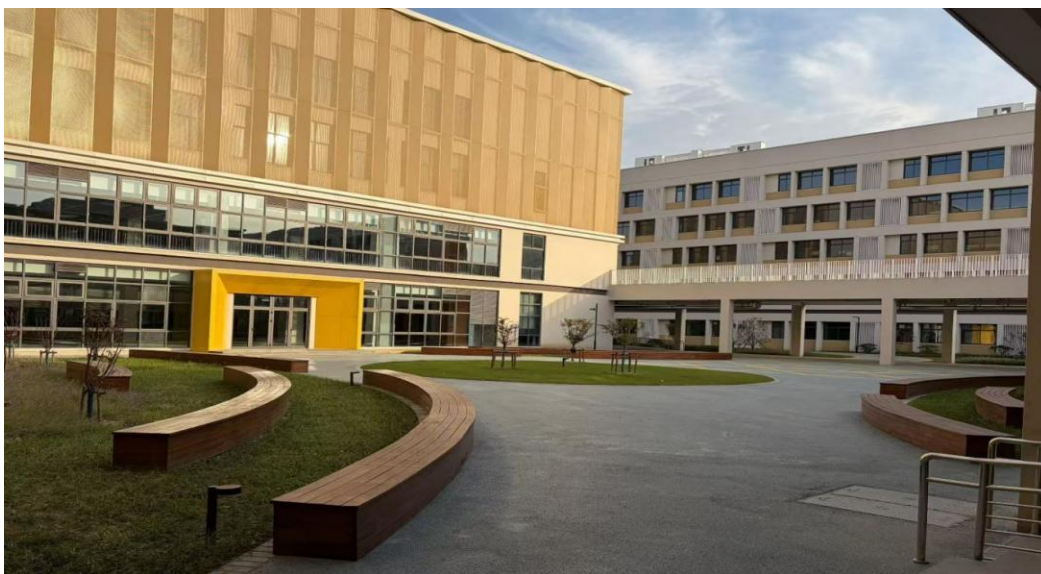
图1 项目现场实景图
