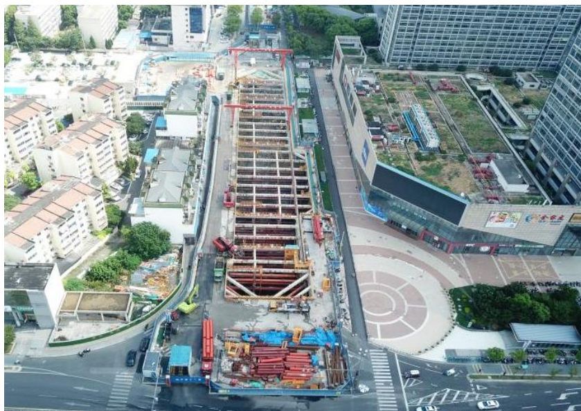
图1 旺庄路站基坑现场实景实拍图
