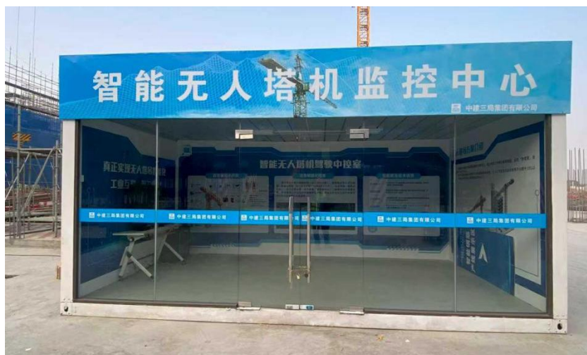
图8 智能无人塔机驾驶监控中心实景图1
