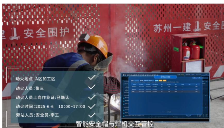
图12 智能安全帽与电焊机联动
