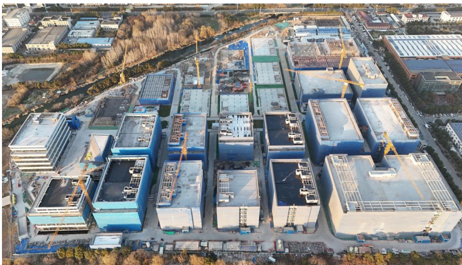
图2 项目施工现场实景图
