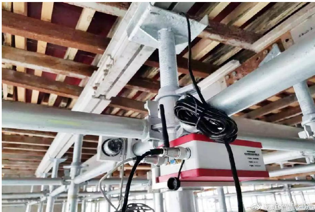
图3 高支模监测预警装置现场照片
