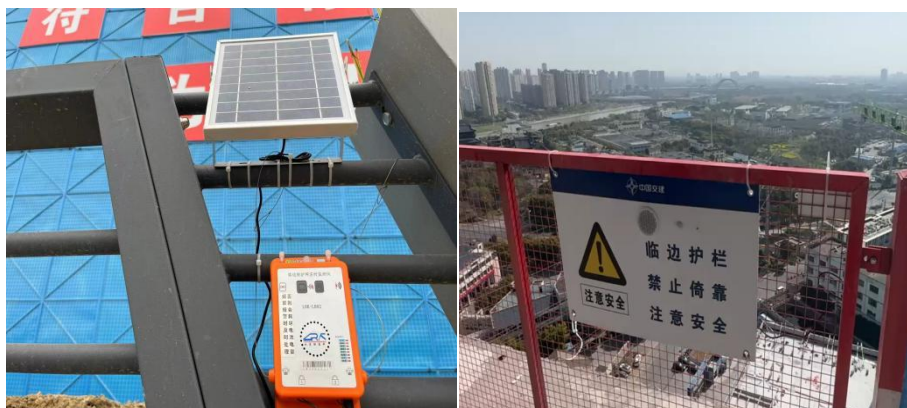
图6 护栏智能警报系统及语音实时警告功能
