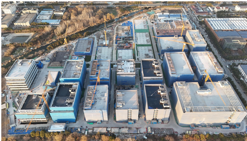
图2 项目施工现场实景图
