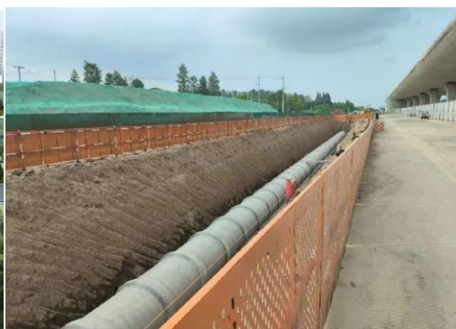
图2 现场管道施工
