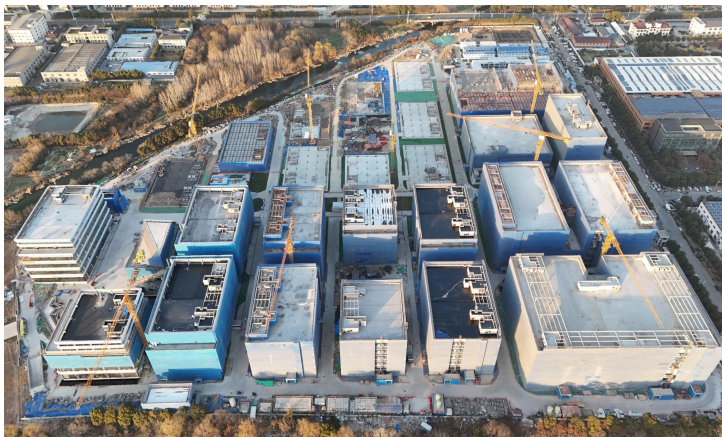
图2 项目施工现场实景图
