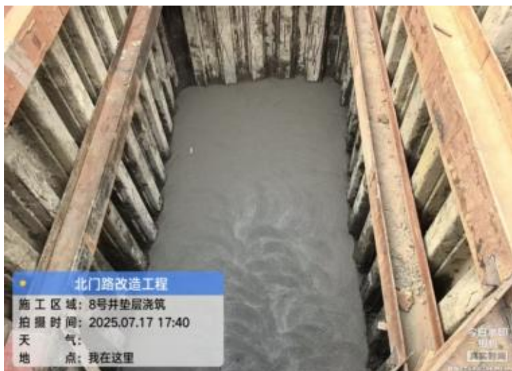
图3 超深基坑实景图
