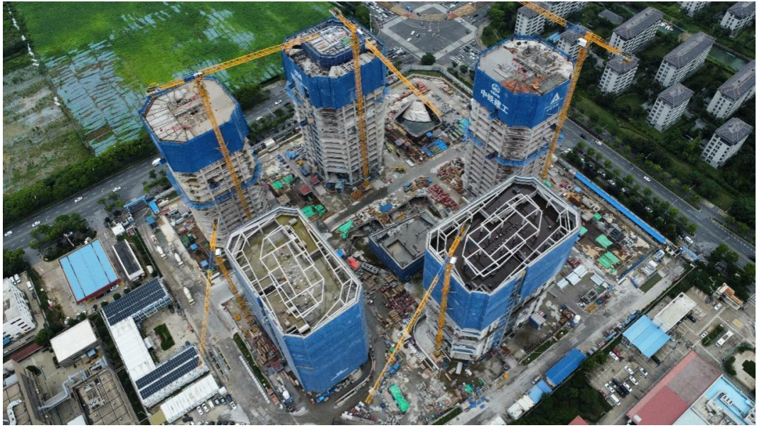
图1 项目现场航拍实景图
