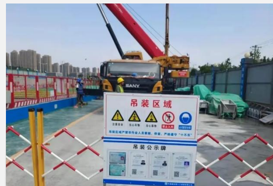
吊装区域警示
