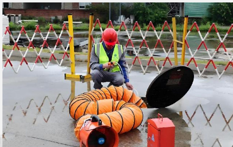
先通风、再检测、后作业、有监护
