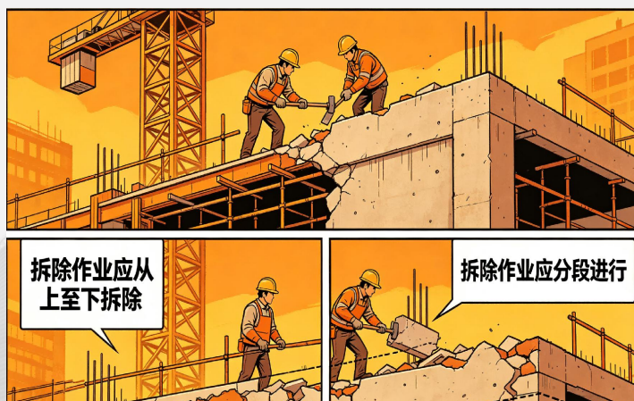
按方案的顺序进行拆除
