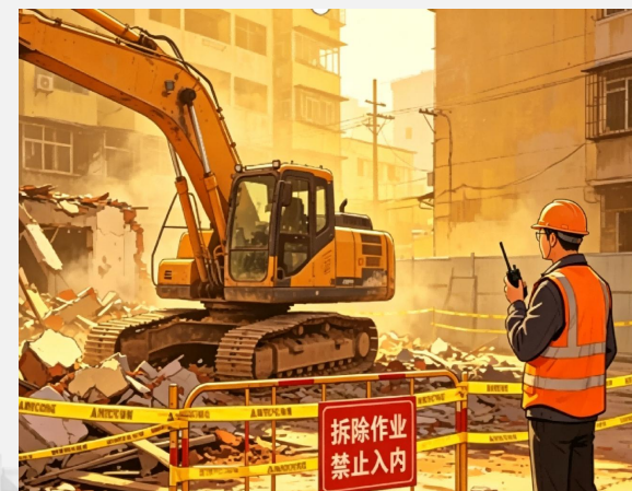
拆除作业监护
