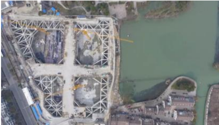
围堰、基坑工程俯视图
