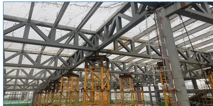
钢结构底部满挂水平兜网
