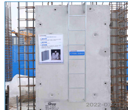
PC吊装登高施工机具
