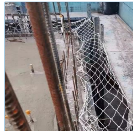
层间隔离（附着式升降脚手架）
