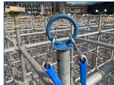
模板支架搭设安全带系挂点
