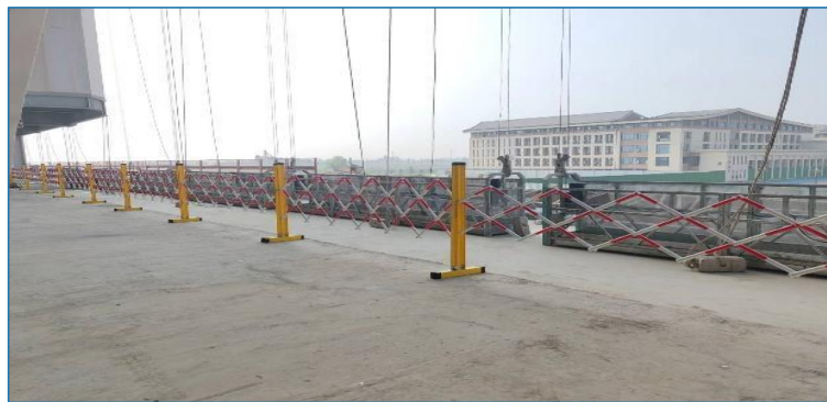
吊篮作业区采用隔离围挡封闭
