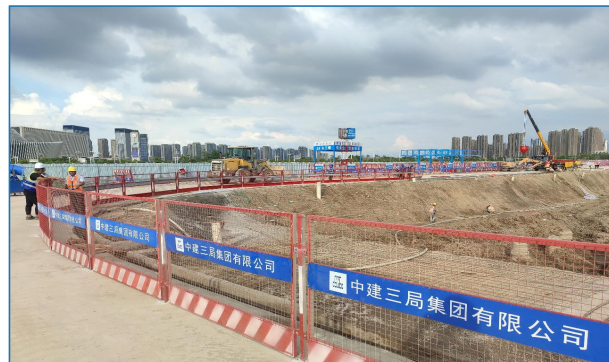
基坑临边定型化防护
