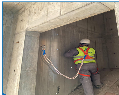
自动卡扣式安全带系挂点
