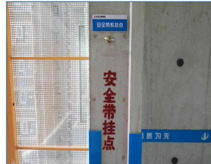
自动卡扣式安全带系挂点
