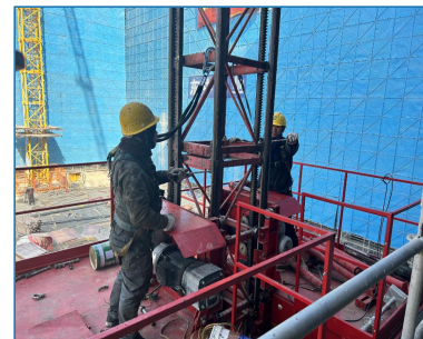
拆除作业安全带系挂
