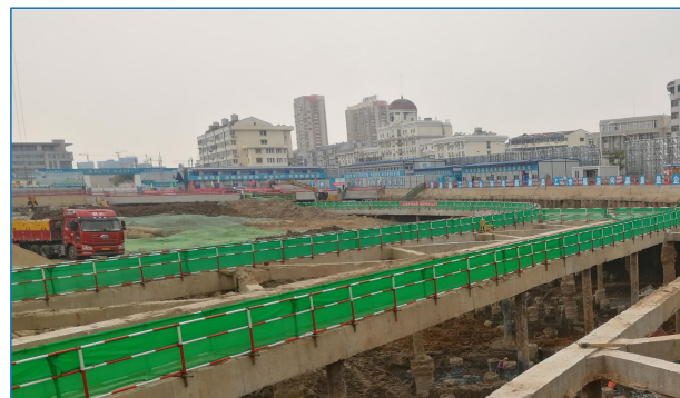
内支撑钢管防护
