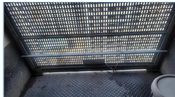
施工电梯加装防冲撞档杆
