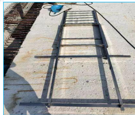
横隔板施工作业垂直挂篮
