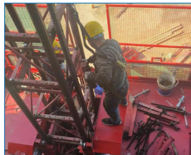
安装作业安全带系挂
