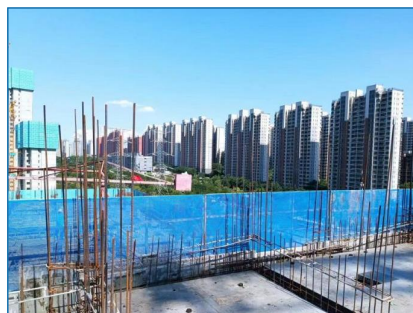
结构断面临边防护
