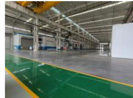
重载地面平整坚实
