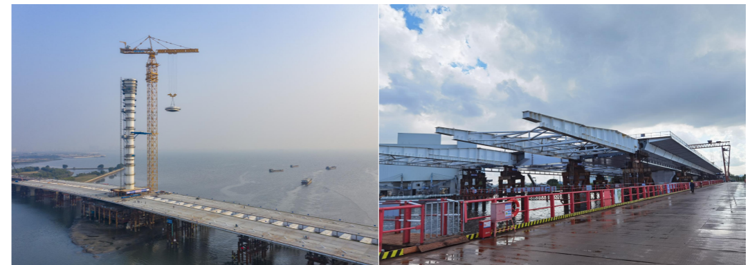
主塔节段吊装
