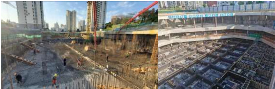
图 1 现浇钢筋混凝土调蓄池示意图
