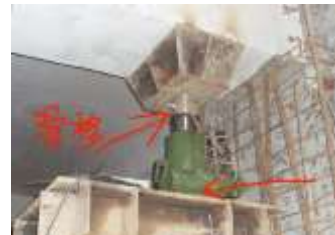
图 22 千斤顶支撑顶加压
