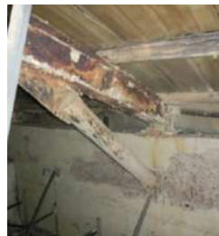
图 4 IV 级钢结构受损情况
