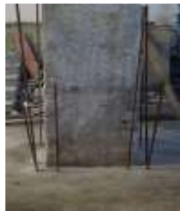
图 20 柱钢筋成孔植筋图
