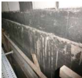
图 1 IIb 级梁受损情况
