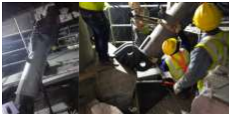
图 12 钢斜撑液压顶升结构安装
