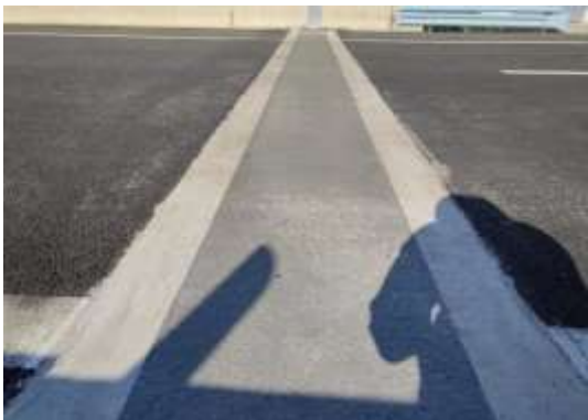
泰州南绕城桥梁无缝伸缩缝
