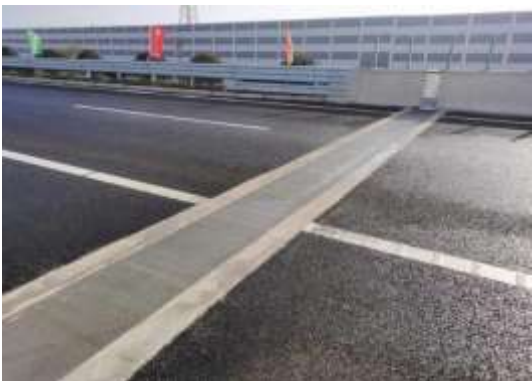
漂宁高速桥梁无缝伸缩缝
