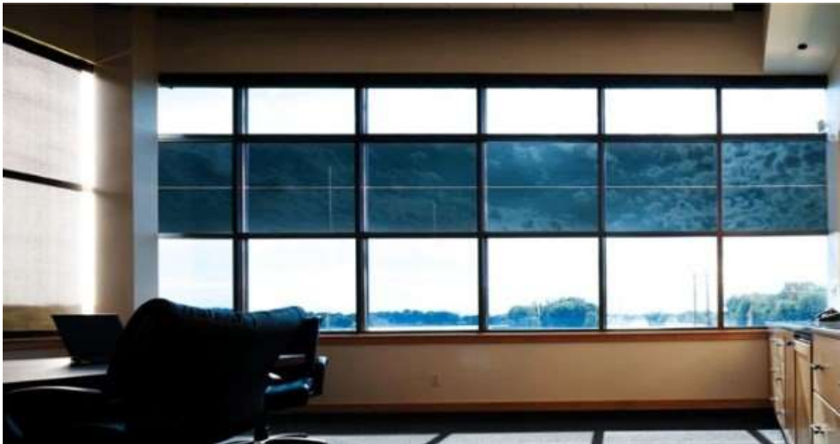
图 5-1 建筑用电致变色玻璃
