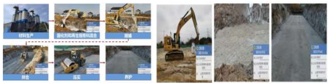
图8 工业废渣协同建筑垃圾再生骨料固化淤泥工程应用
