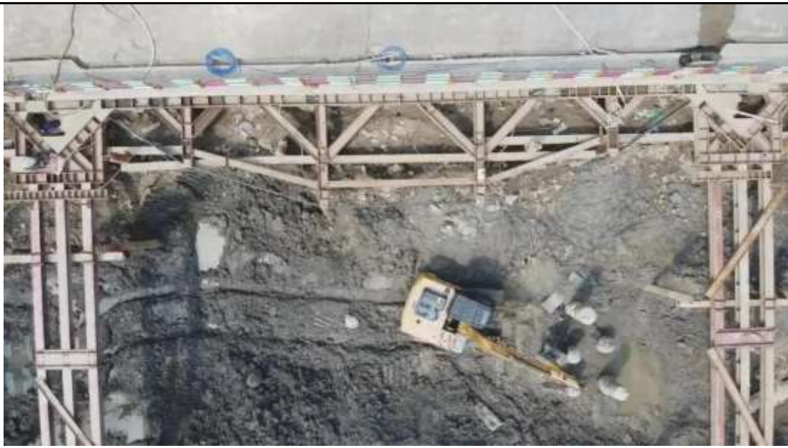
图 2.6 预应力鱼腹式基坑钢支撑
