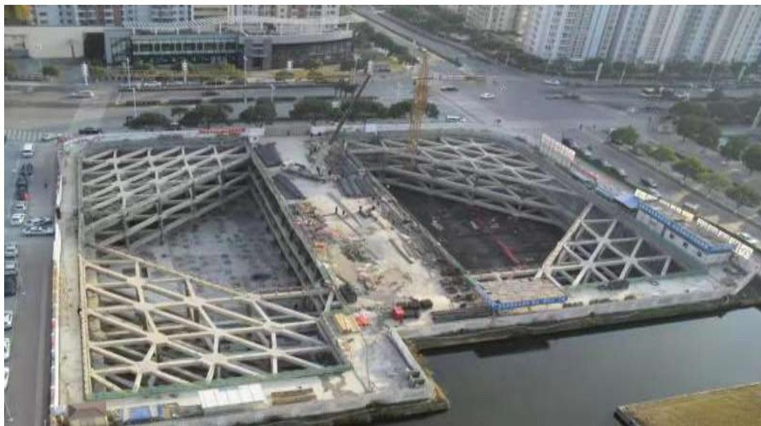
图 2.1 传统钢筋混凝土内支撑
