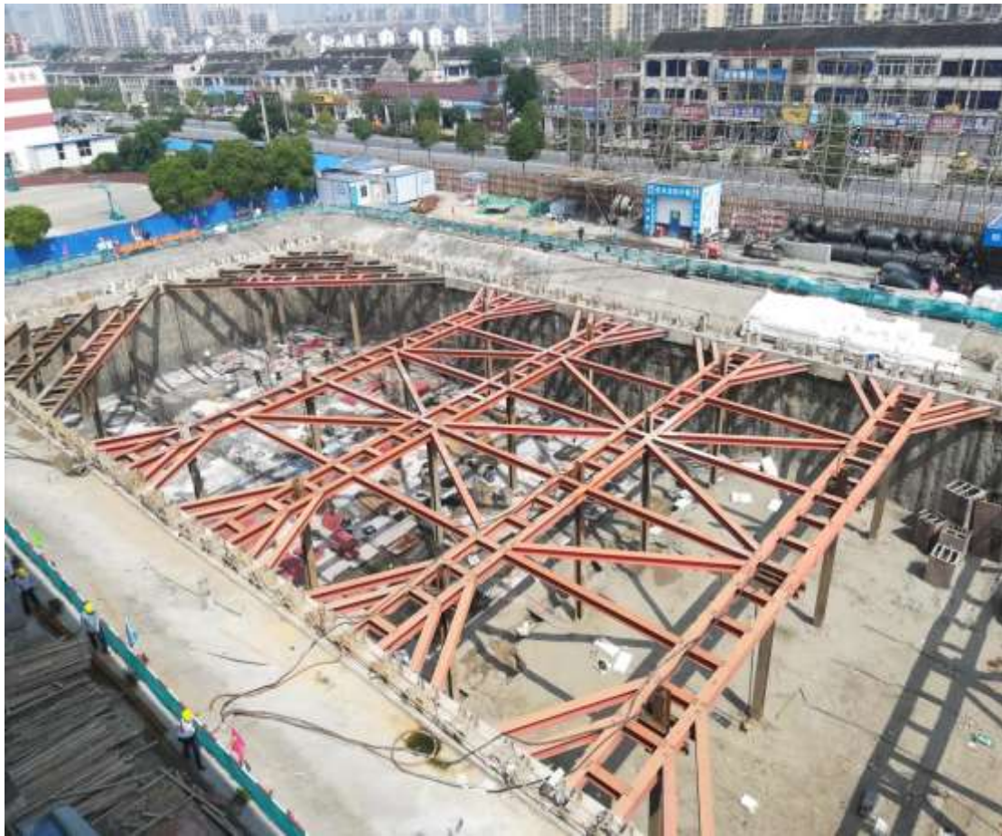
图 2.3 装配式（组合）钢支撑
