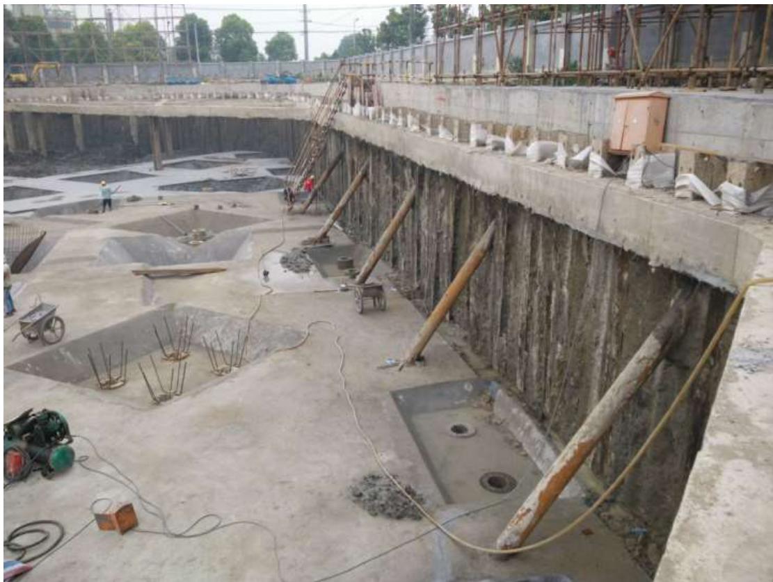
图 2.7 自稳式基坑支护组合技术
