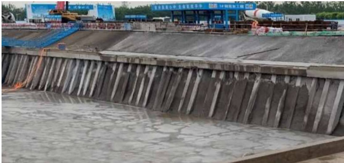
图 2.9 无支撑（斜桩）支护
