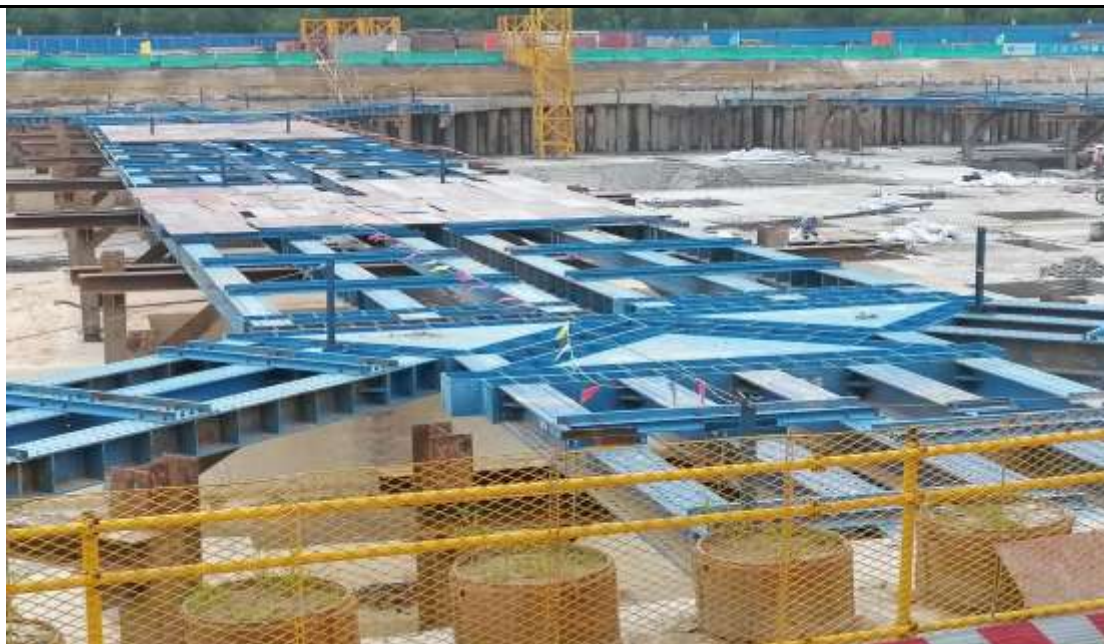
图 2.4 装配式（组合）钢支撑
