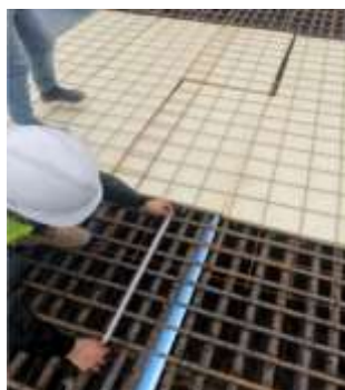
图 13 定型化接驳器限位装置安装
