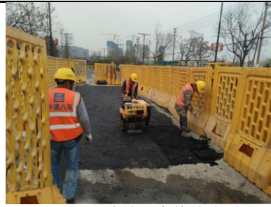
图 3.3-4 冷补沥青修补路面
