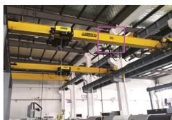
无吊车厂房增设吊车梁
